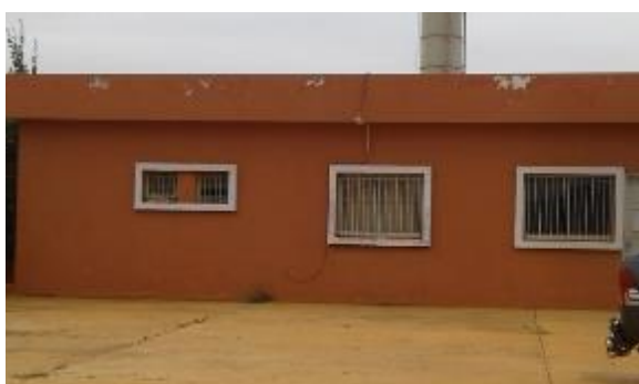
C. Bâtiments de bureau sur le site
