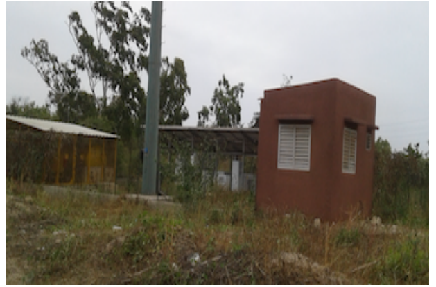
B. Station d'antenne de télécommunication de la SONATEL
