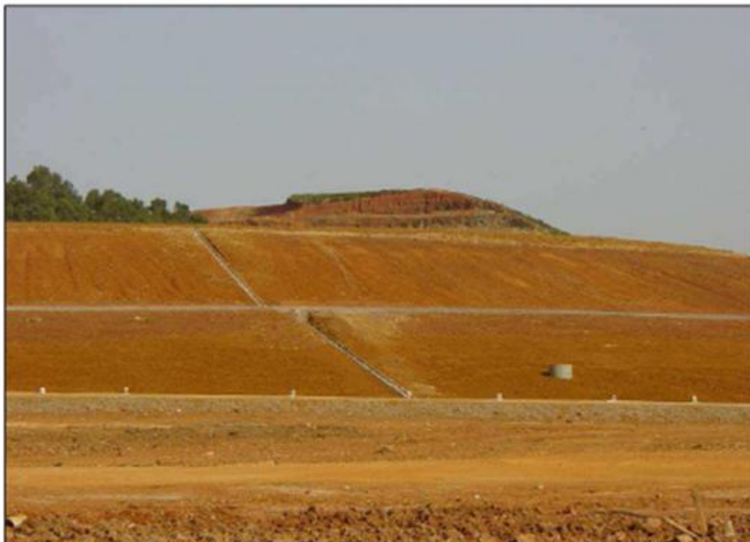
Exemple de réhabilitation de talus
