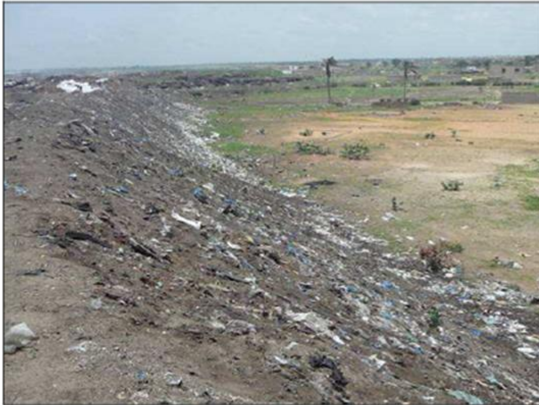
Aspect actuel des talus
